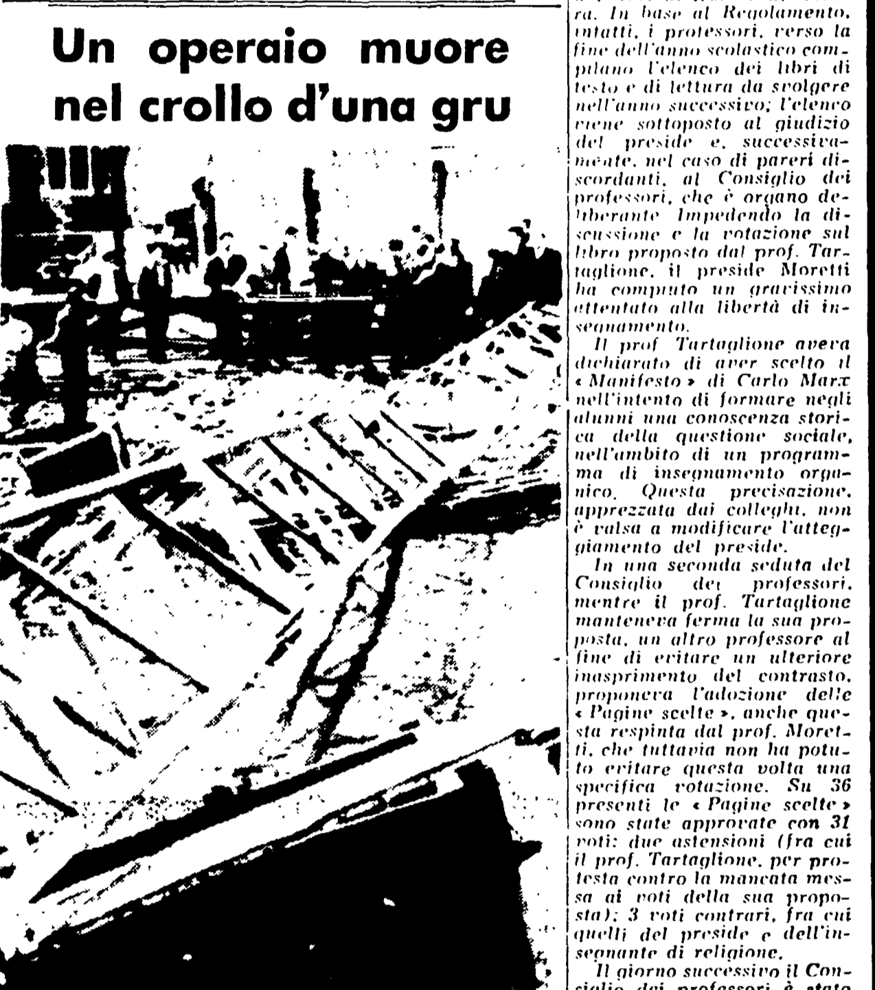
MILANO — Un operaio, Mario Agliardi, è rimasto imprigionato sotto le strutture di una gru, crollata verso mezzogiorno in un cantiere di Viale Certosa 123, durante una fase di montaggio. L'Agliardi, che ha riportato fratture multiple è poi deceduto all'Ospedale Maggiore.
