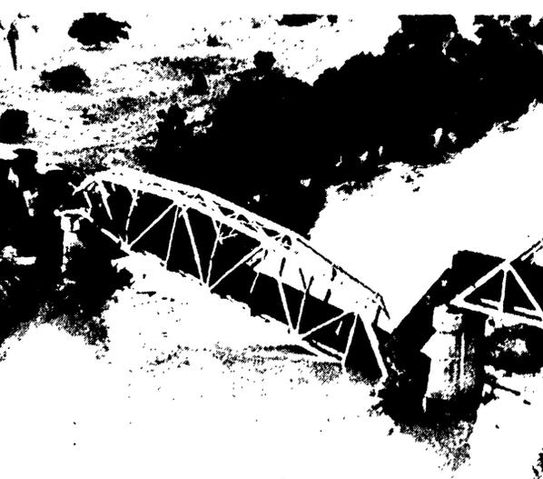
WEST POINT (Texas). — Una veduta aerea di un ponte metallico crollato al passaggio di un treno merci composto di 36 vetture che trasportavano acciaio. Fortunatamente non si sono avute vittime. Il ponte crollò sul fiume Colorado, e crollò sotto il peso del convoglio. Si vedono abbastanza chiaramente le vetture prigioniere dell'infelicitosa volta che nel tratto centrale è semiaffondato nel fiume.
