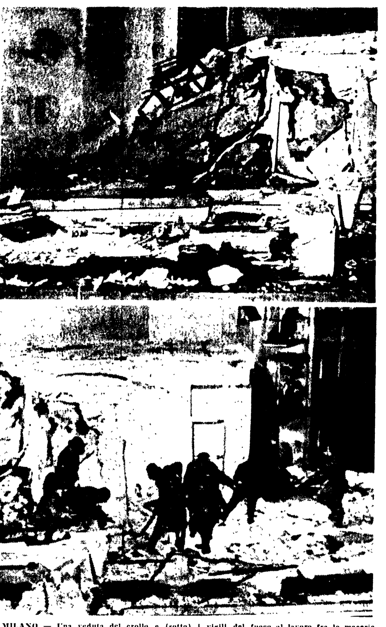
MILANO — Una veduta del crollo e (sotto) i vigili del fuoco al lavoro fra le macerie (Telefoto)
