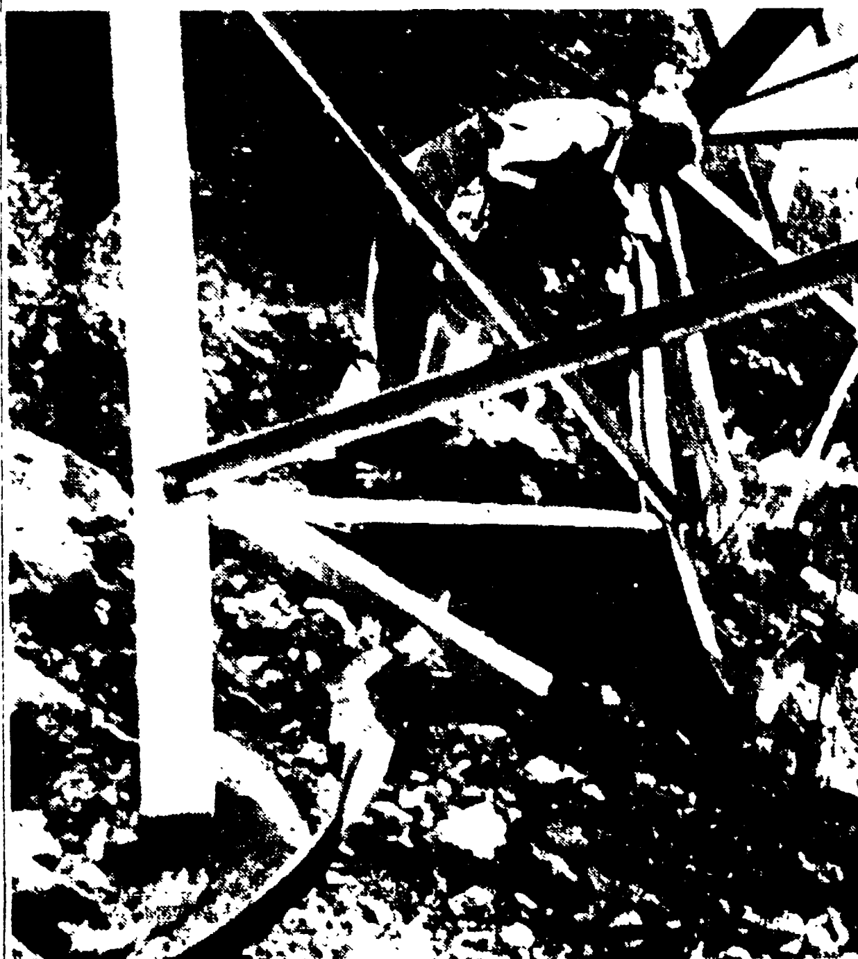
BOLZANO - La base di un pilone fatto saltare nei pressi di Cortaccia. La base del pilone è completamente distrutta e contorta. Tra le strutture un fotografo osserva i danni prodotti dalla carica di plastico.
