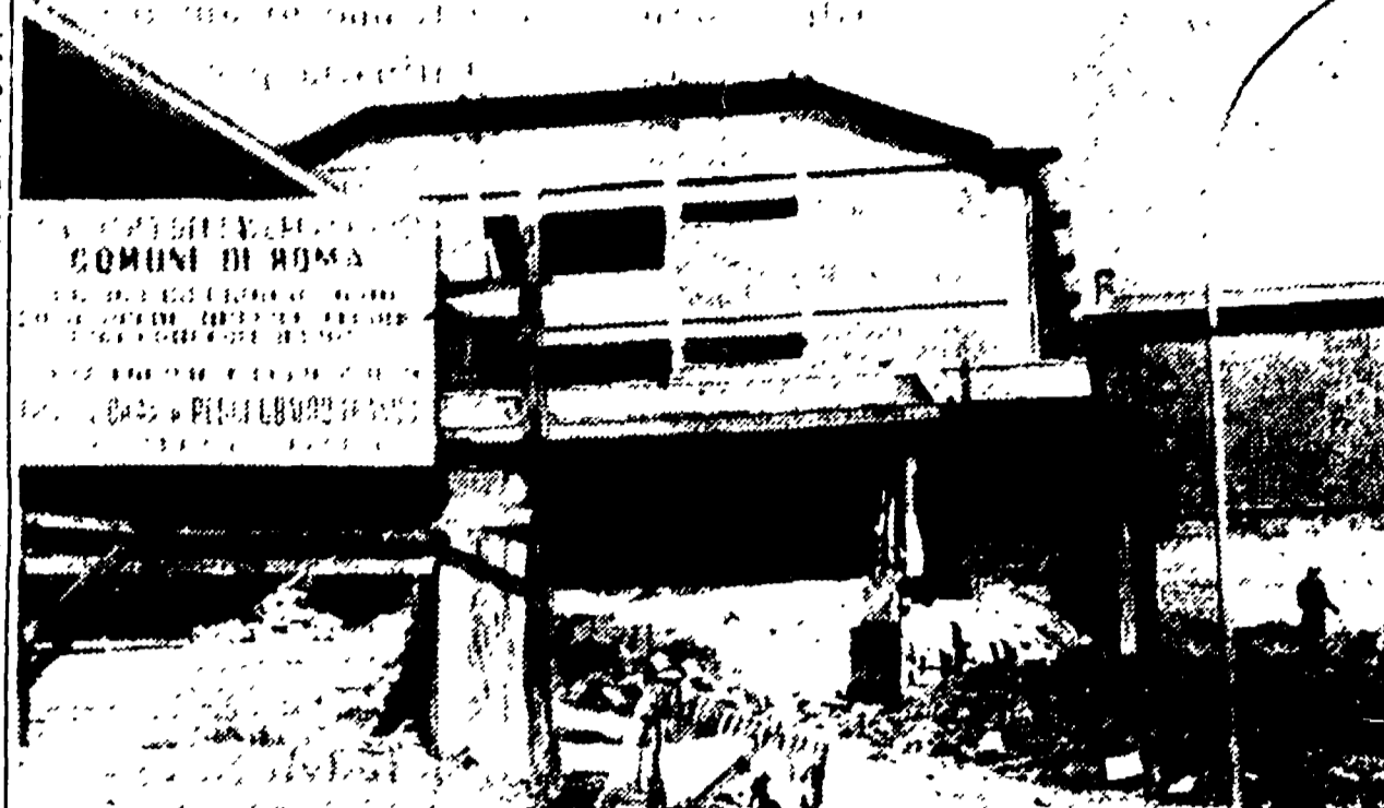
FLAMINIO - La scuola di via della Maratona. Sei aule dell'edificio costruito per le classi elementari e per l'asilo, ospiteranno le medie. La decisione è stata presa all'ultimo momento, a causa dell'assoluta mancanza di aule per le medie esistenti nel quartiere.
