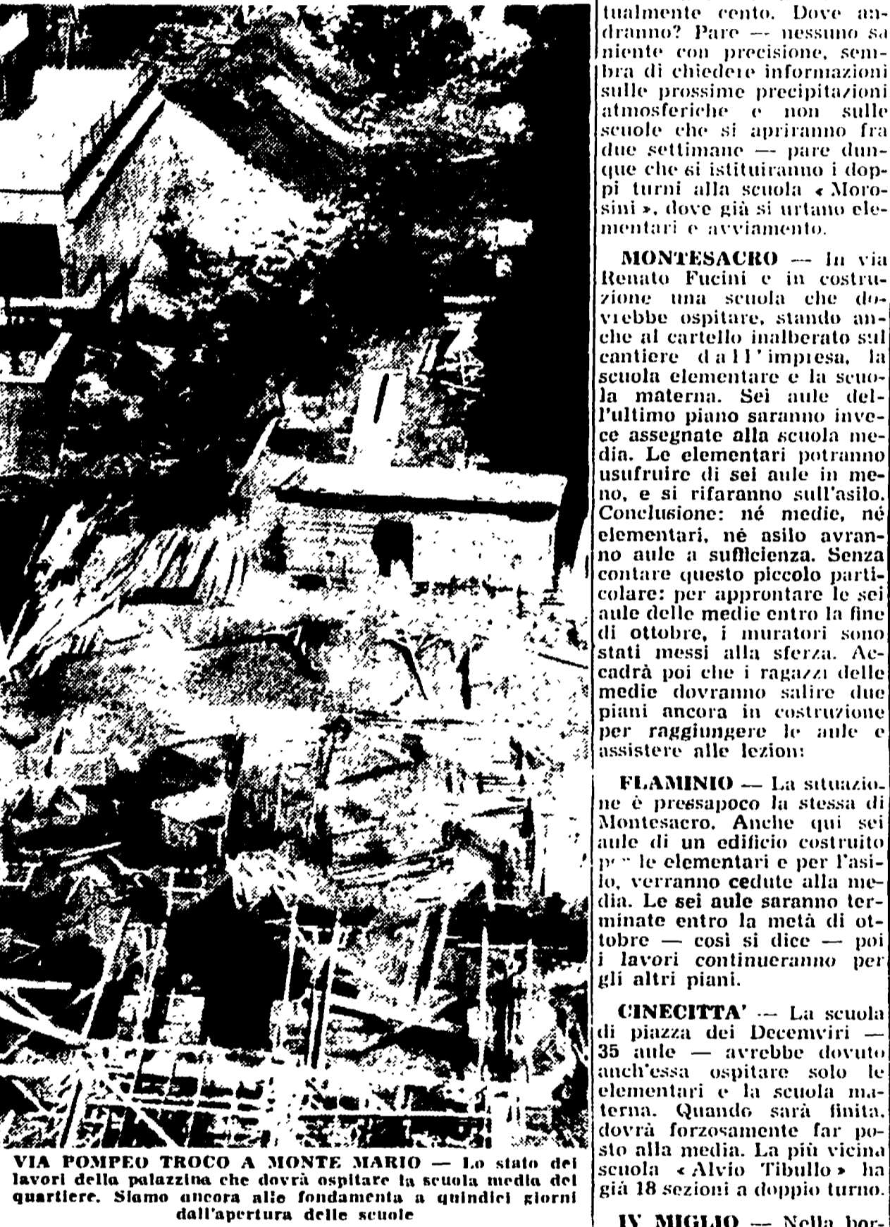
VIA POMPEO TROCÒ A MONTE MARIO - Lo stato dei lavori della palazzina che dovrà ospitare la scuola media del quartiere. Siamo ancora alle fondamenta a quindici giorni dall'apertura delle scuole.
