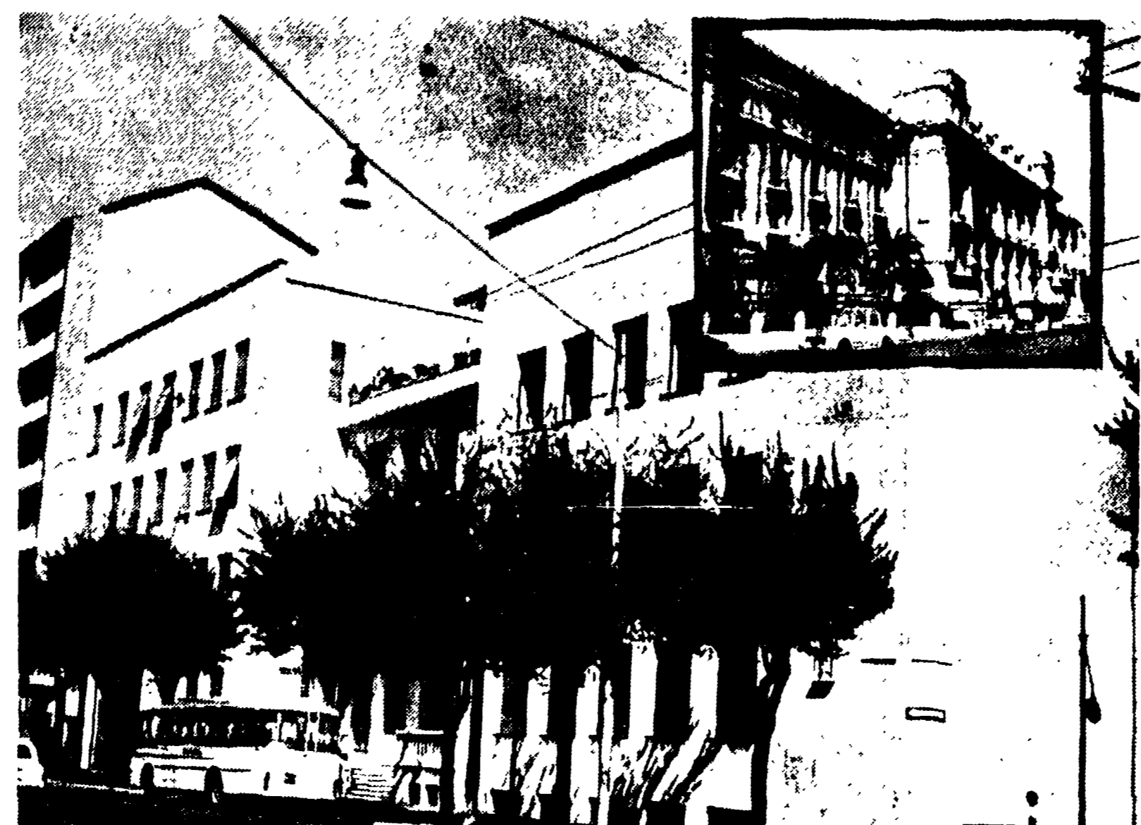
Ecco due volti della stessa realtà: due foto scattate in Trastevere, a pochi passi dal ministero della Pubblica Istruzione, ci danno un'immagine perfetta delle condizioni della scuola italiana.
