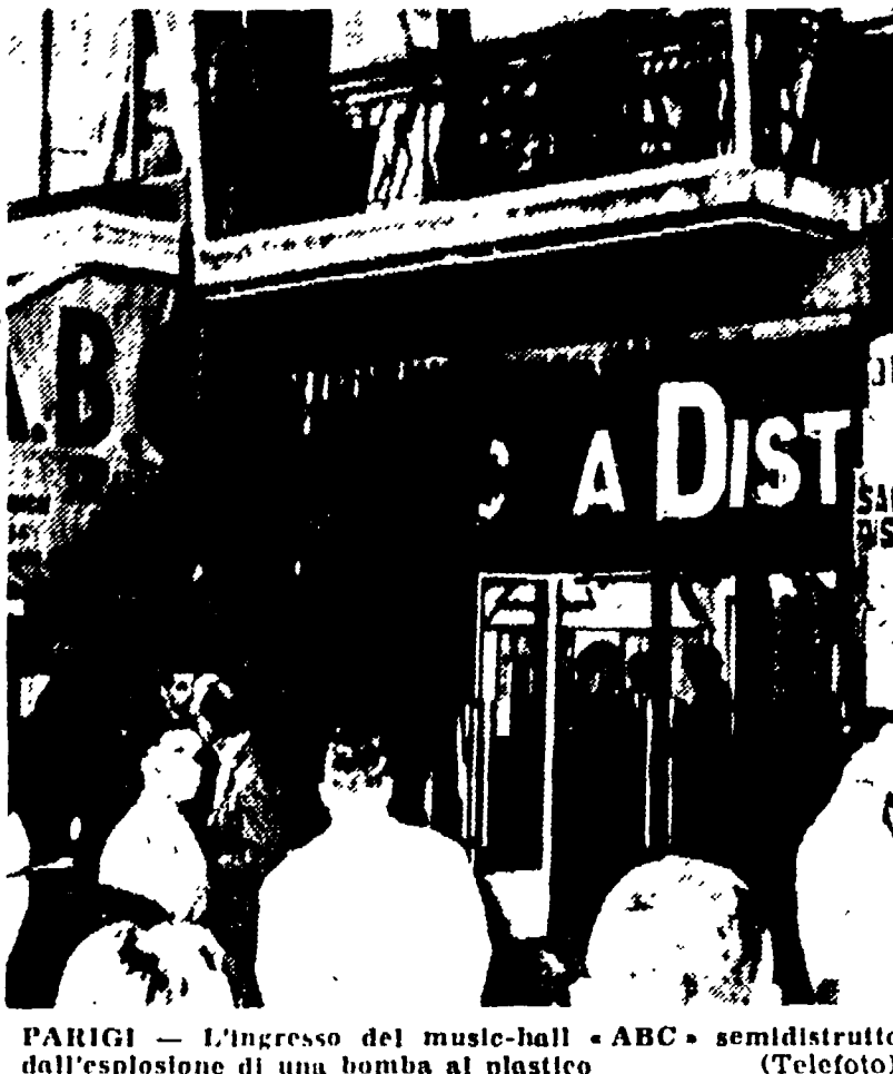
PARIGI — L'ingresso del music-hall « ABC » semidistrutto dall'esplosione di una bomba al plastico (Telefoto)
