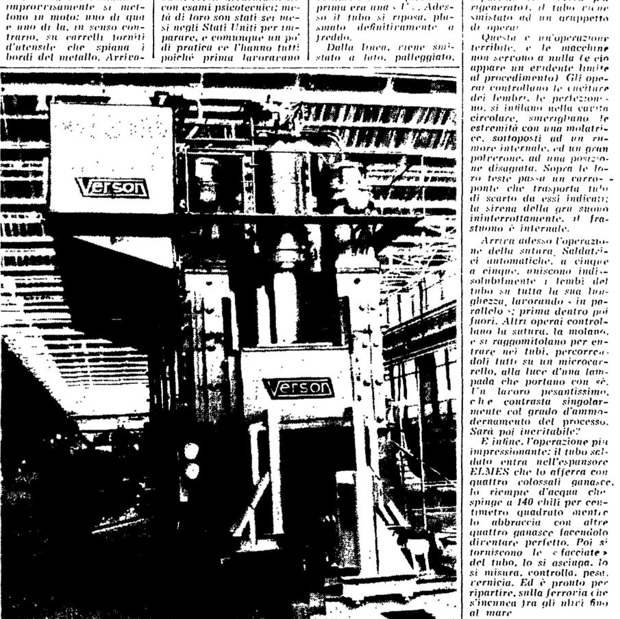
TARANTO — La pressa a «O», ove la lamiera, dopo essere stata sagomata dalla pressa ad «U», viene sottoposta ad una pressione pari a 16.200 tonnellate, per essere resa cilindrica
