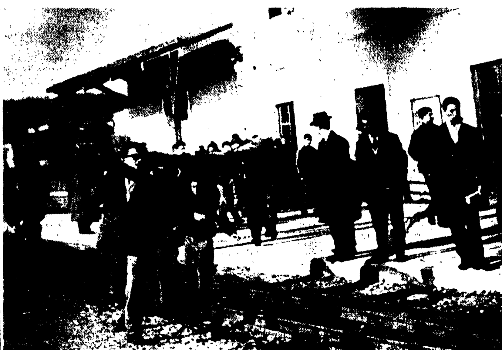
SOVERIA MANNELLI - La collera popolare in seguito alla sciagura sulle «Calabro-Lucane» dove hanno trovato la morte 70 persone, è esplosa ieri incontestabile. Nella foto si notano appunto alcuni cittadini che bloccano il traffico ferroviario ponendo delle pesanti traversine sulle rotaie
