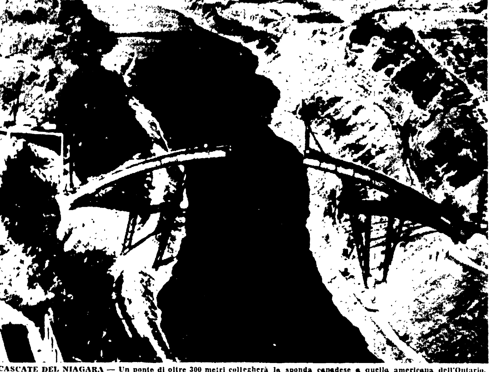
CASCATE DEL NIAGARA — Un ponte di oltre 300 metri collegherà la sponda canadese a quella americana dell'Ontario. Questa veduta aerea mostra l'ardito sviluppo della costruzione. (Telefoto A.P.—Unità)
