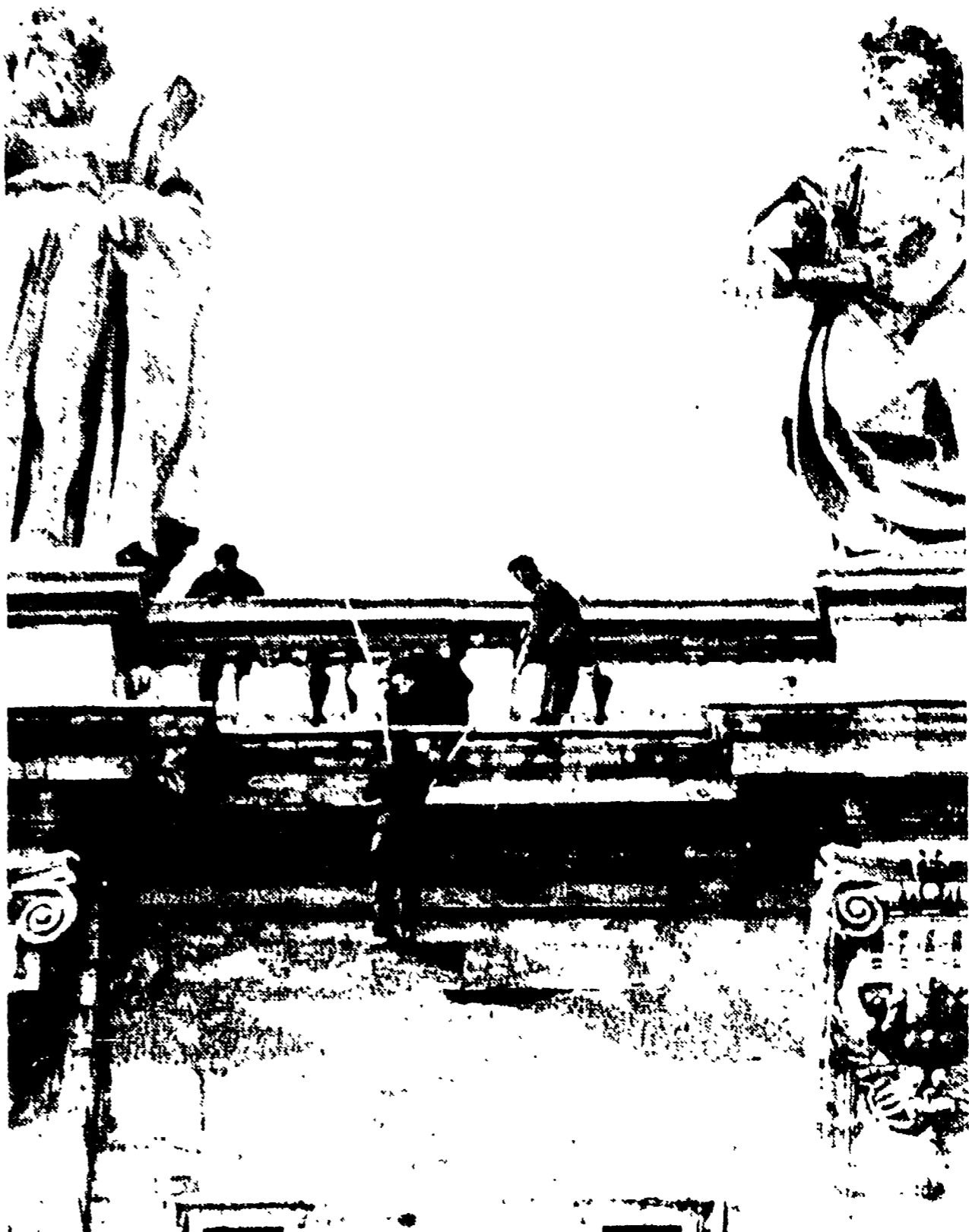
In allarme i tecnici della fabbrica di S. Pietro, dopo il crollo — inaspettato — della gamba dell'angelo che, con una statua gemella, sarebbero stati provanti della basilica, ieri, minuziosi controlli sono stati eseguiti sulla facciata del tempio. Gli esami non sono ancora terminati, ma pare che urgano delicati lavori di restauro: danni a statue, colonne e balaustrate. Infatti, sarebbero stati provocati dall'ultima ondata di maltempo. Nella foto: un tecnico sospeso nel vuoto
