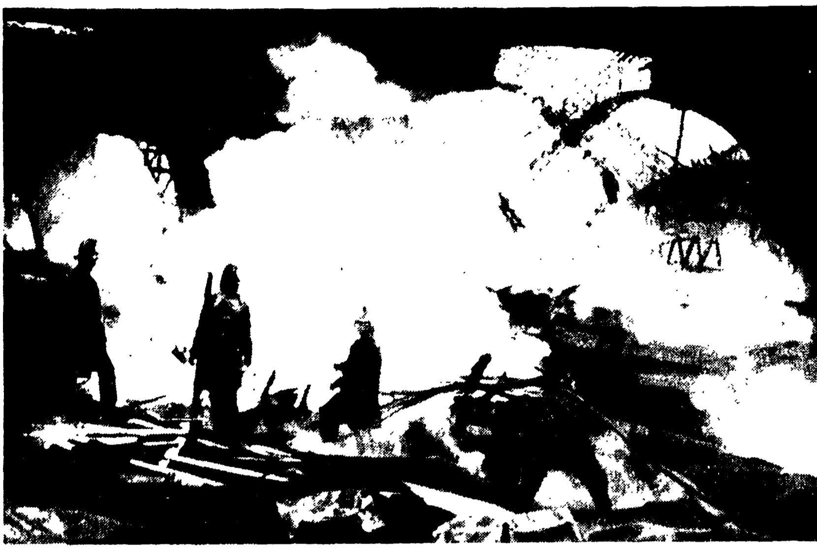
CITTA' DEL MESSICO, 15. — Un colossale incendio sviluppatosi ieri sera nel centro della capitale messicana ha semidistrutto i cantieri per la costruzione della nuova sede dell'ambasciata degli Stati Uniti a Città del Messico.
