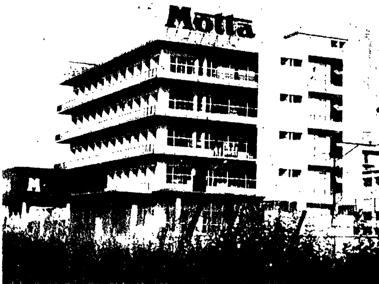
Uno dei più recenti stabilimenti installati a Napoli
