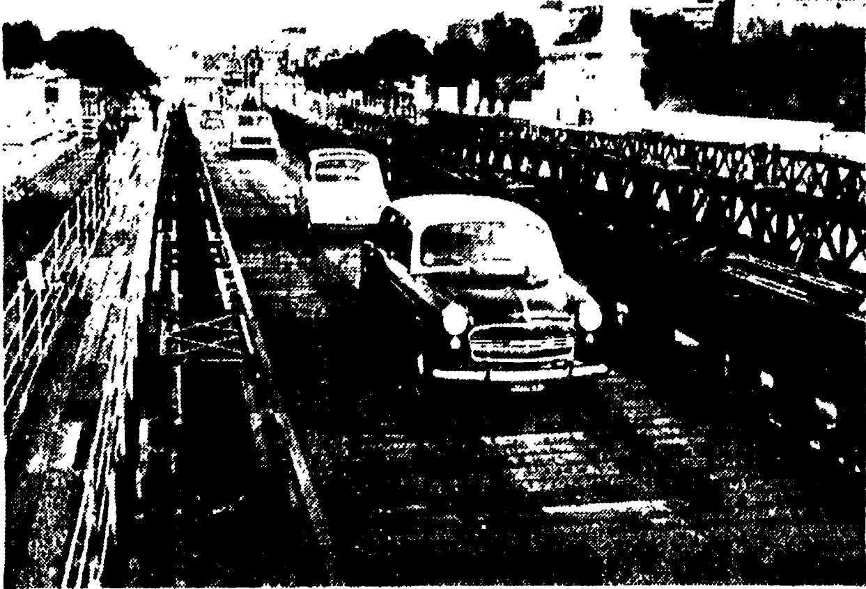
Ieri mattina il monumento al cardine, chiuso da quattro metri in seguito al cedimento di un pilone, è stato riaperto al traffico con una soluzione... di guerra. Il Genio Civile ha difatti gettato sul pilone un ponte di passerelle del tipo « bailey », usate dagli Alle-
