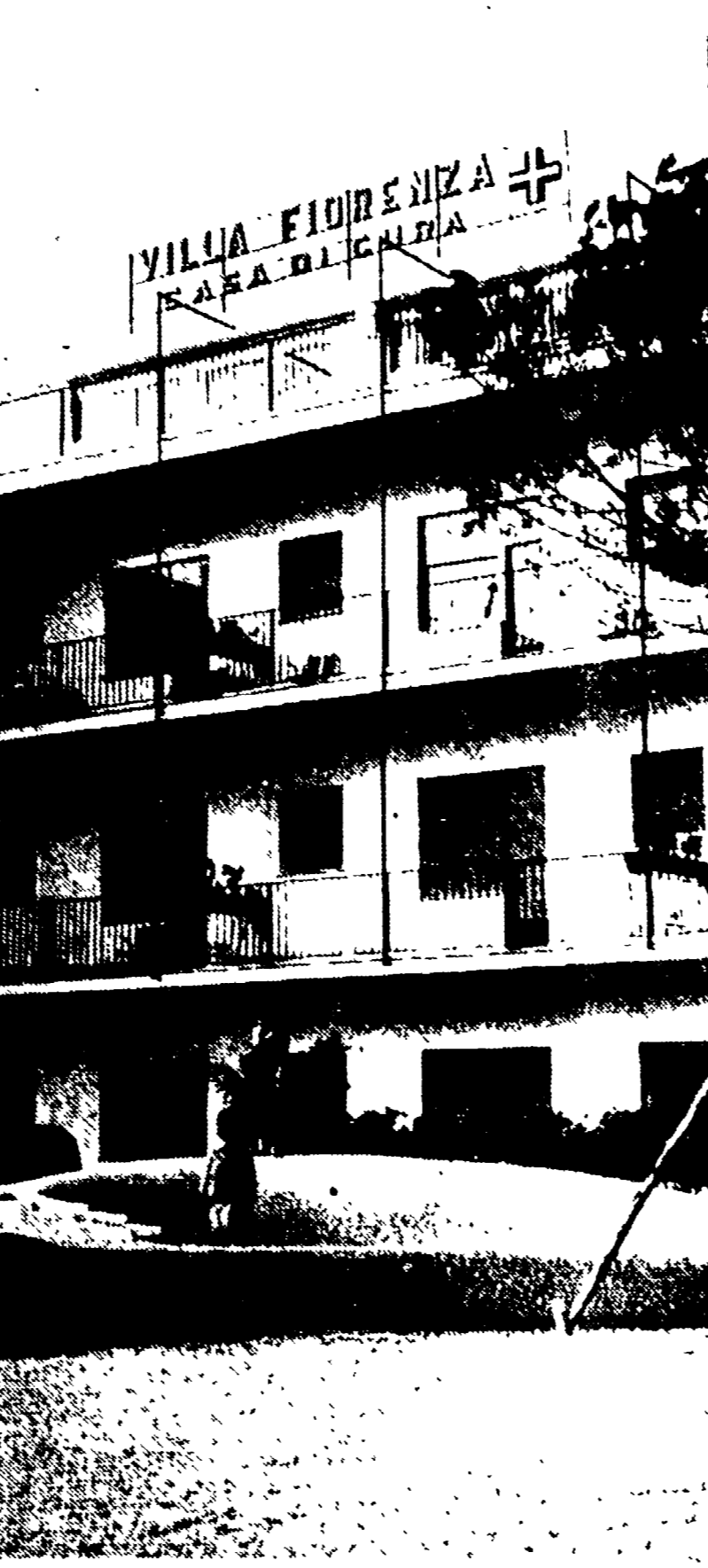
La facciata della nuova clinica
