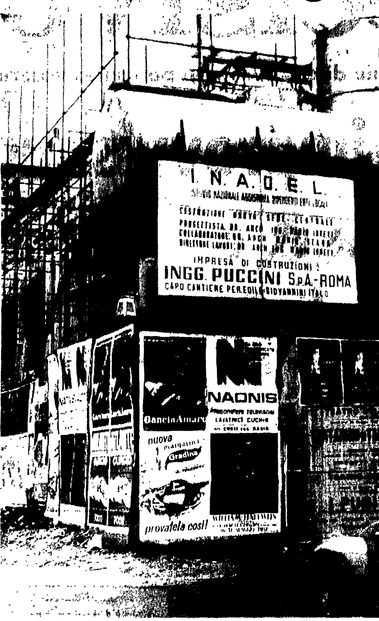
La nuova sede dell'Istituto che minaccia di far crollare due palazzi
