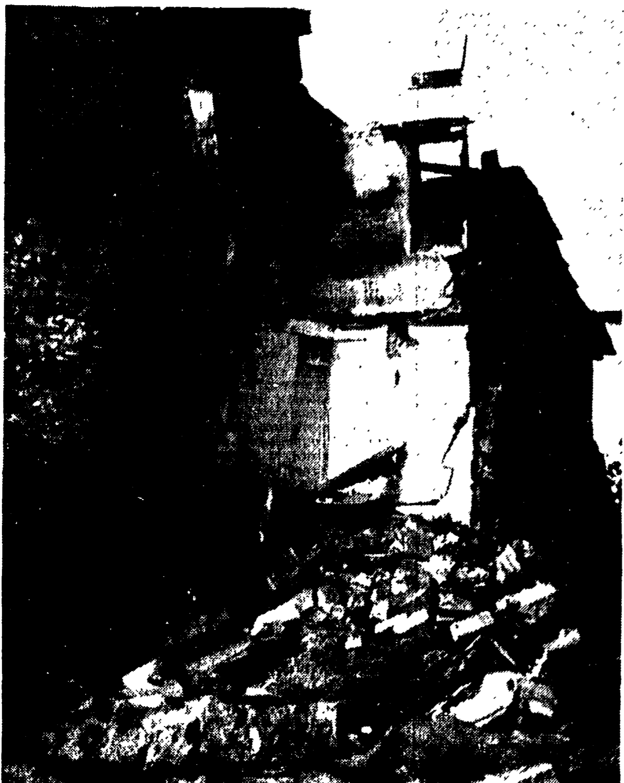
VIA DELLA CAFFARELETTA: le macerie della casetta abbattuta dalle acque.
