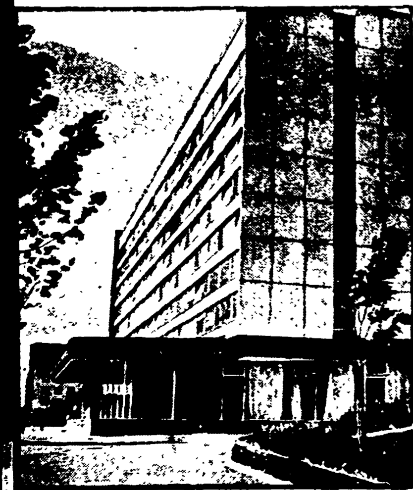
Mosca, albergo « Iunost », terminato di recente
