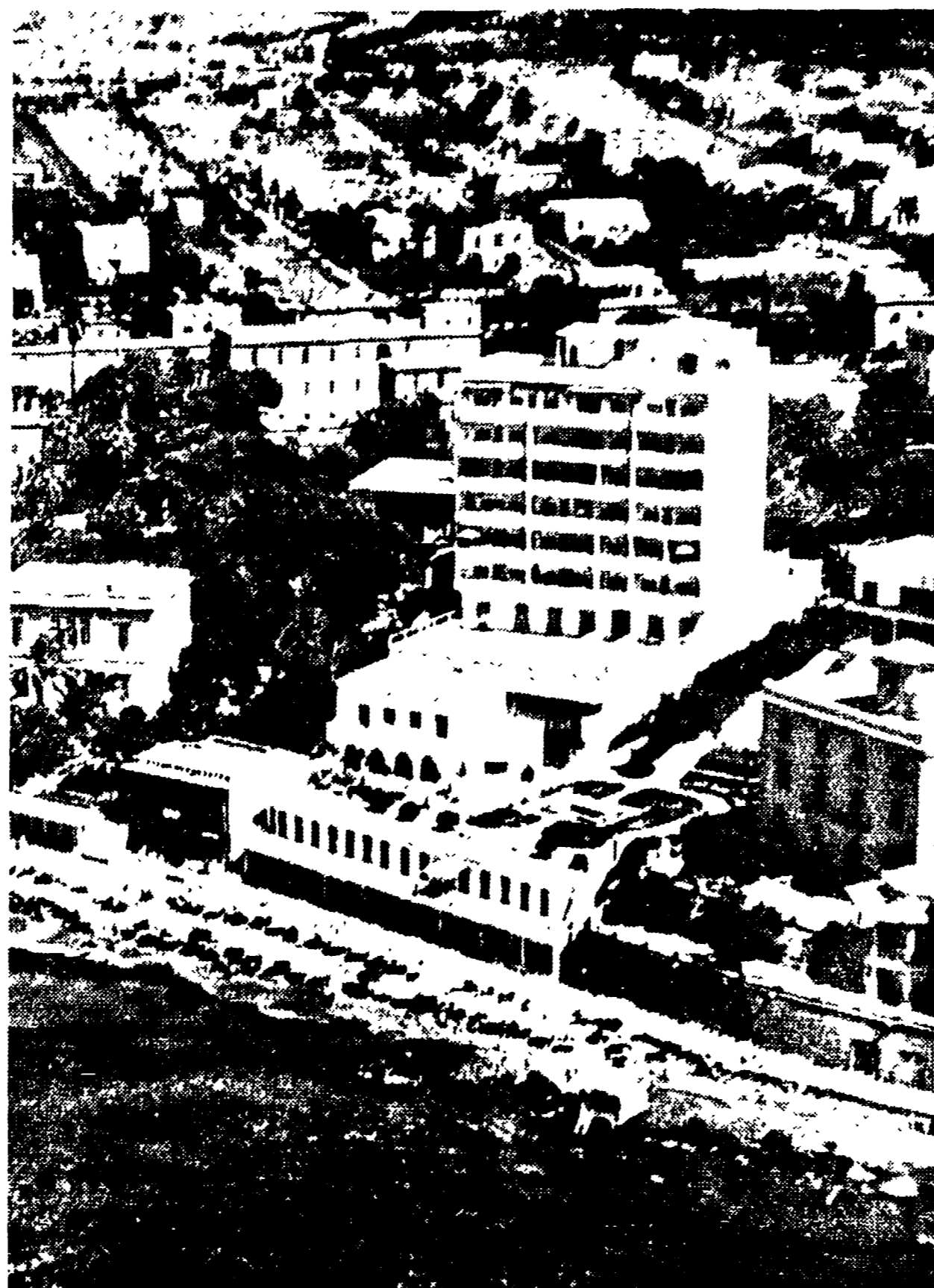
Uno dei blocchi di cemento sorti a Santa Marinella in riva al mare
