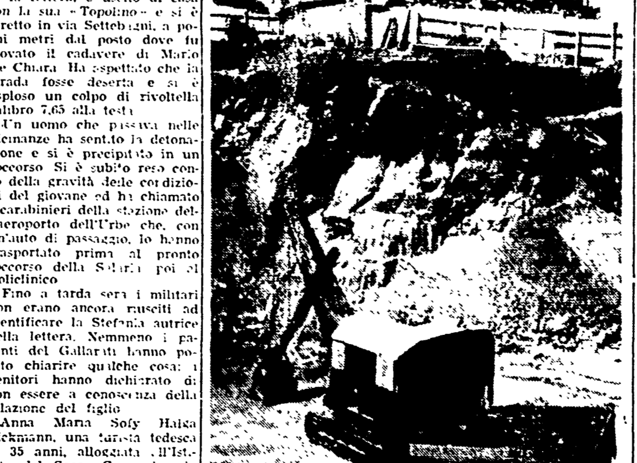
Cinque casette di via S. Colombano all'EUR rischiano di crollare da un momento all'altro, perché una ruspa dell'impresa Santaroni ha lesionato le loro fondamenta. Per la costruzione di un nuovo palazzo, l'impresa ha scavato una voragine di 20 metri proprio a ridosso delle casette, per le quali gli inquilini pagano l'affitto al Comune. Sul muro delle case si sono già aperte minacciose crepe: le cinghiale famiglie che vi abitano saranno costrette ad abbandonarle, se gli scavi non verranno sospesi. (Nella foto: la ruspa sotto le casette pericolanti).
