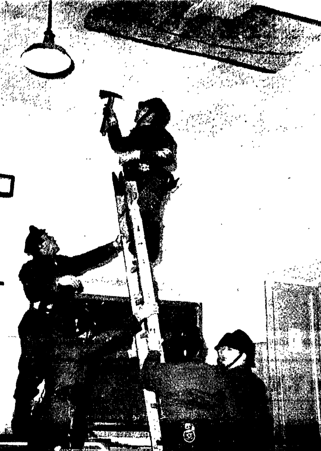
Crollo di calcinacci e momenti di panico ieri alle ore 17 fra gli studenti della I G dell'Istituto commerciale «Vilfredo Pareto» di via Capo d'Africa: durante la lezione di geografia è crollato sulle teste degli allievi parte dell'intonaco del soffitto. Trenta ragazzi si sono precipitati nei corridoi e lungo le scale chiamati dal personale della scuola per timore che veramente stesse per crollare il tetto.
