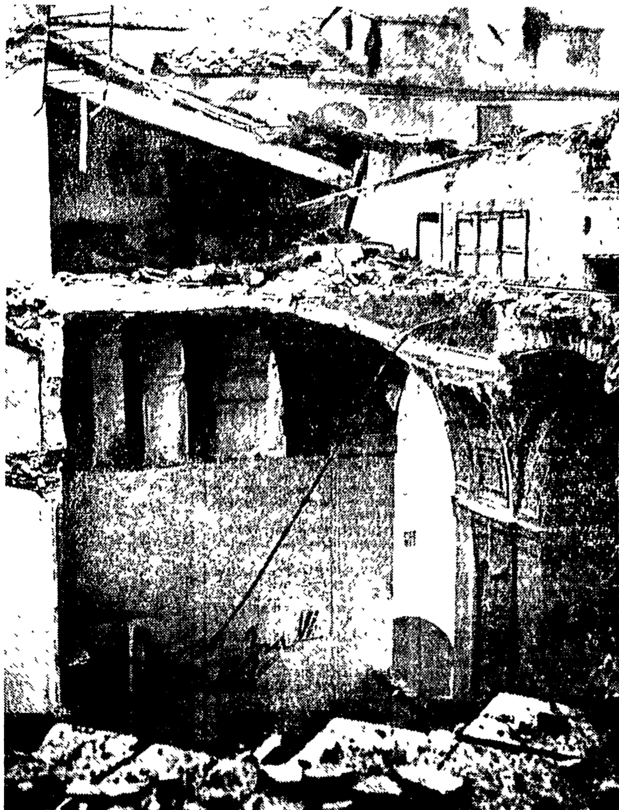
Una drammatica immagine dell'edificio crollato in via San Michele. Su una delle pareti si legge: Viva l'INA
