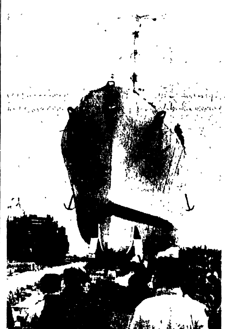
CASTELLAMMARE DI STABIA, 22. Alla presenza del Capo dello Stato, madrina Donna Laura Segni, è stato varato il missile «Caio Duilio»... La nuova unità militare, dovuta al progetto dell'ingegner Francesco Rossi, degli stessi Cantieri IRI di Castellammare, ha un dislocamento di 6 mila tonnellate, una potenza di 60 mila cavalli vapore, otto cannoni da 76,62, due lanciasiluri, una
