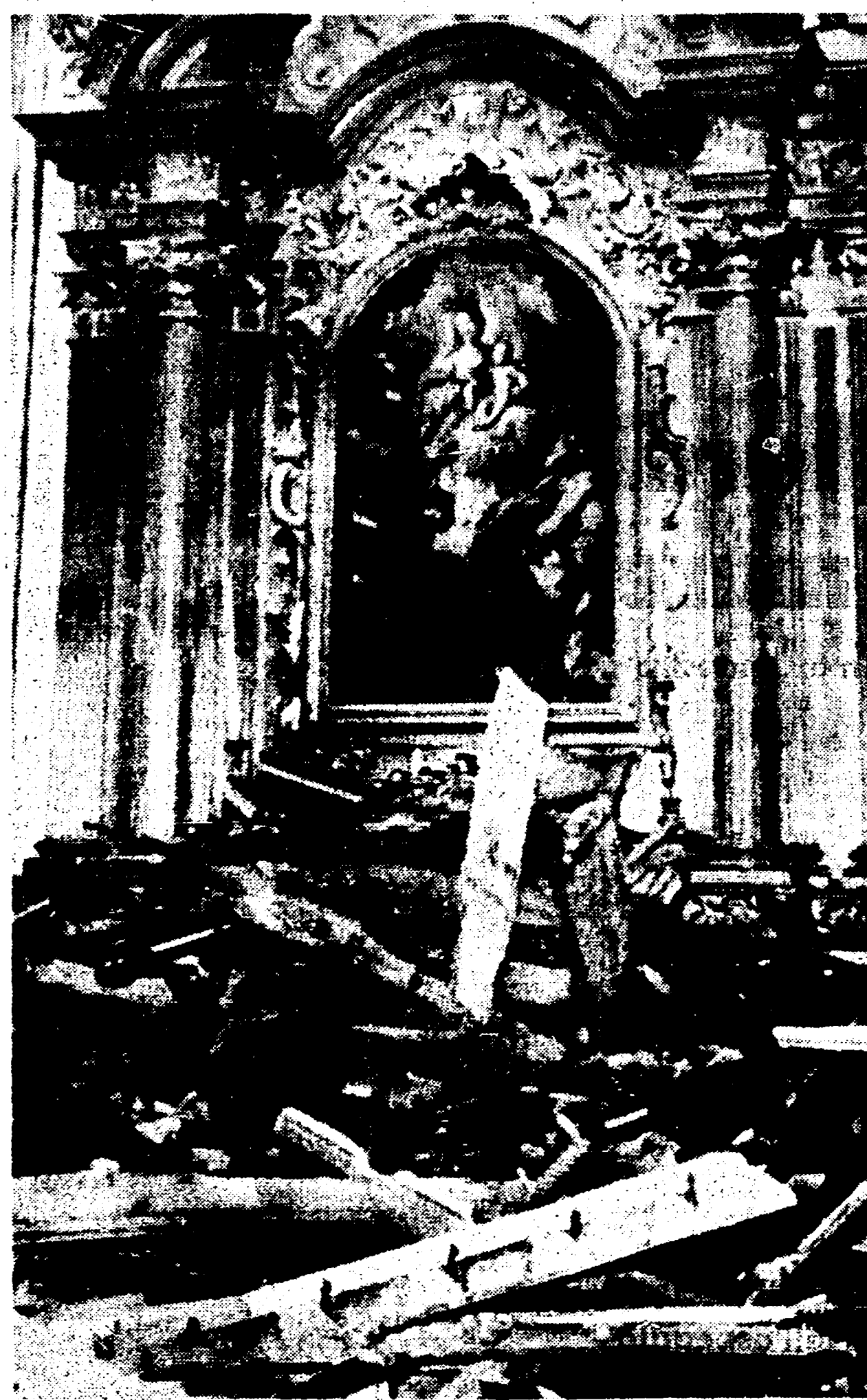
Dal nostro corrispondente
