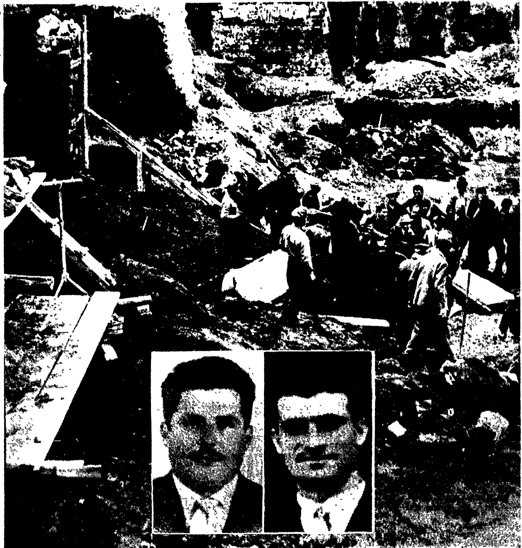
Il cantiere di via Baccarini dove è avvenuta la sciagura. Nelle foto piccole le vittime: Antonio Orsini (a sinistra) e Enrico Chicarella
