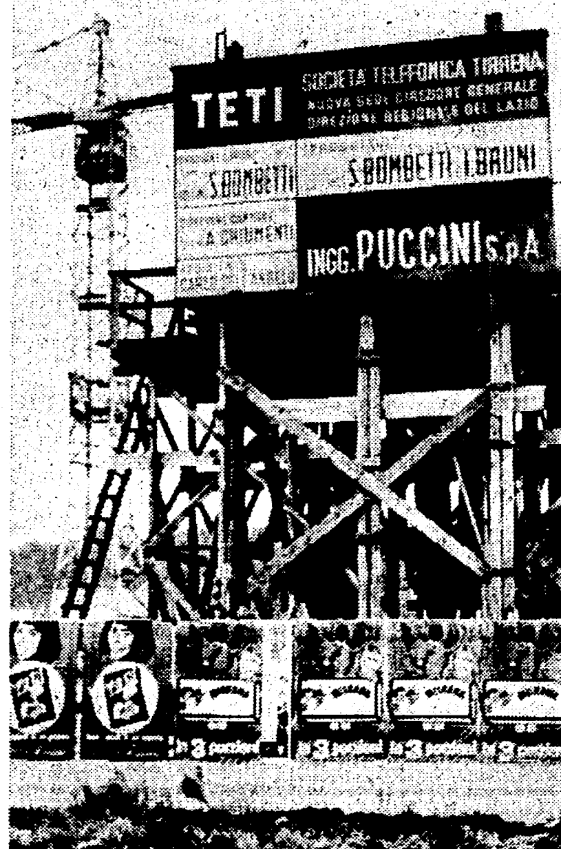
La nuova sede della TETI in costruzione.
