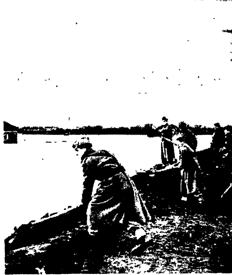
DOLJEVAC — Le inondazioni hanno devastato le campagne della Serbia, provocando danni anche a strade e linee ferroviarie. Nelle telefoto: il ponte ferroviario di Doljevac, che attraversa la Morava, spezzato dalla furia delle acque; anche in forte alluvione sono state mobilitate e qui si vede una squadra di soldati lavorare di badile per tentare di arginare il corso di acqua in piena.
