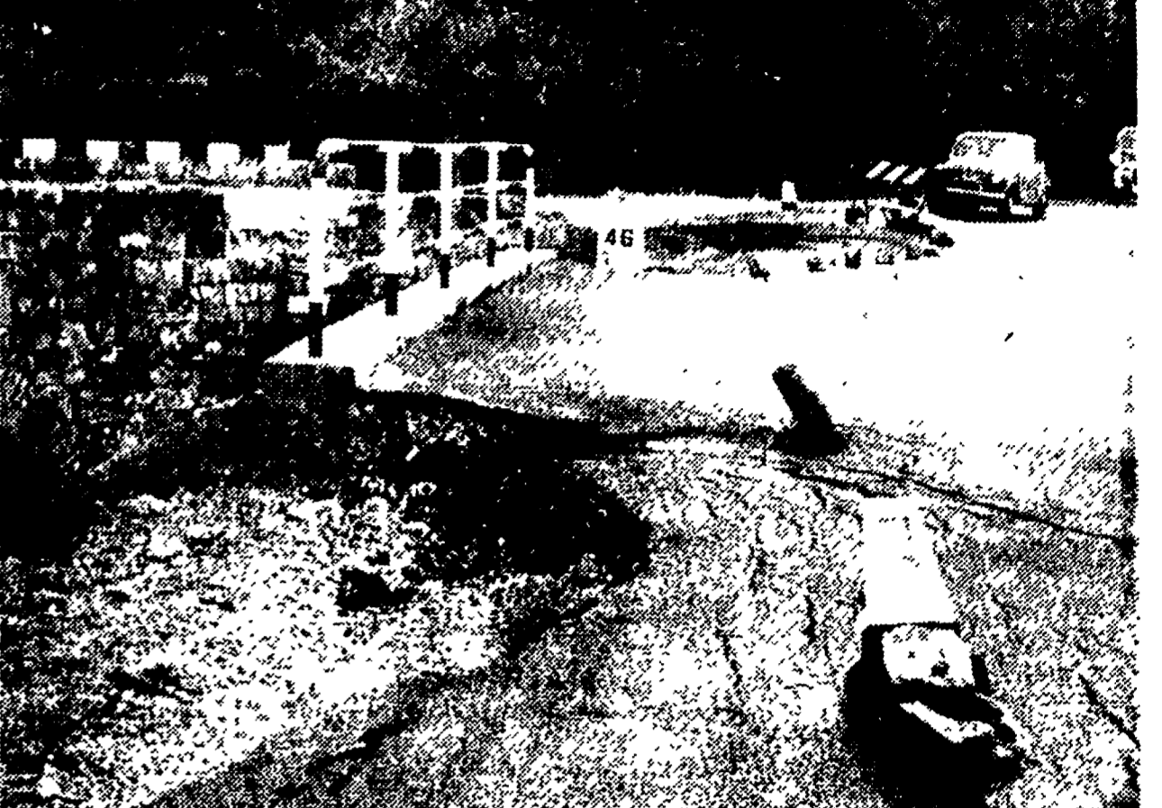
Non ancora finiti i lavori e già franano le strade. Nella foto: la strada « Corleto-Moliterno » tra il bivio di Corleto e Montemurro. Chi pagherà?
