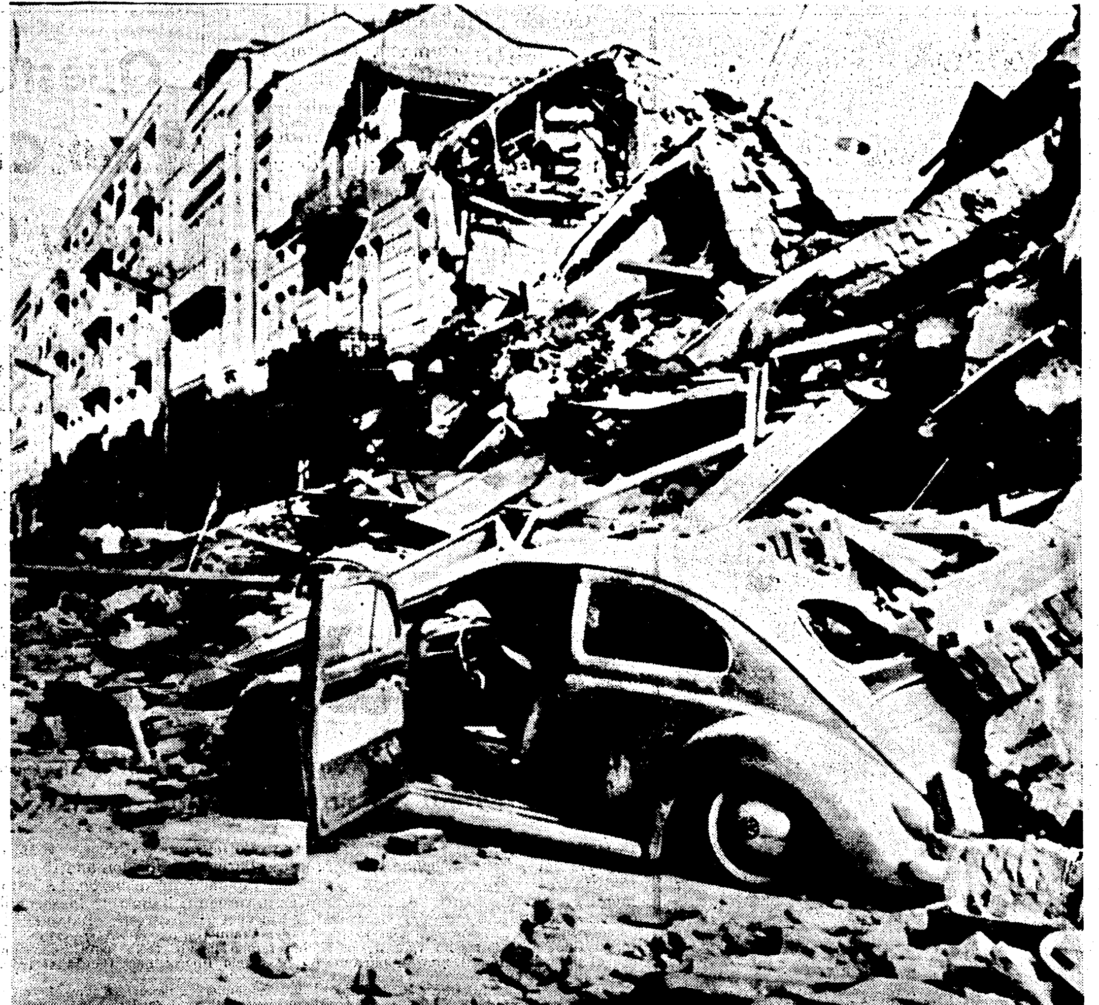
SKOPJE. Ecco che cosa è rimasto di un palazzo del centro della città. Le strutture in cemento armato hanno ceduto alle scosse telluriche e si sono frantumate.
