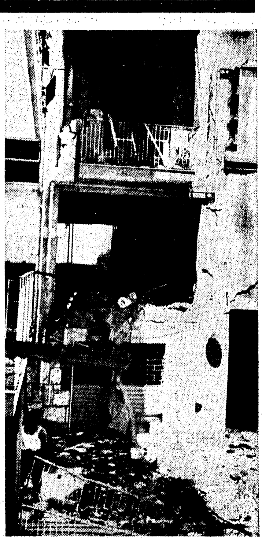
Ecco come si presentava lo stabile subito dopo l'esplosione dovuta, probabilmente, ad una fuga di gas.
