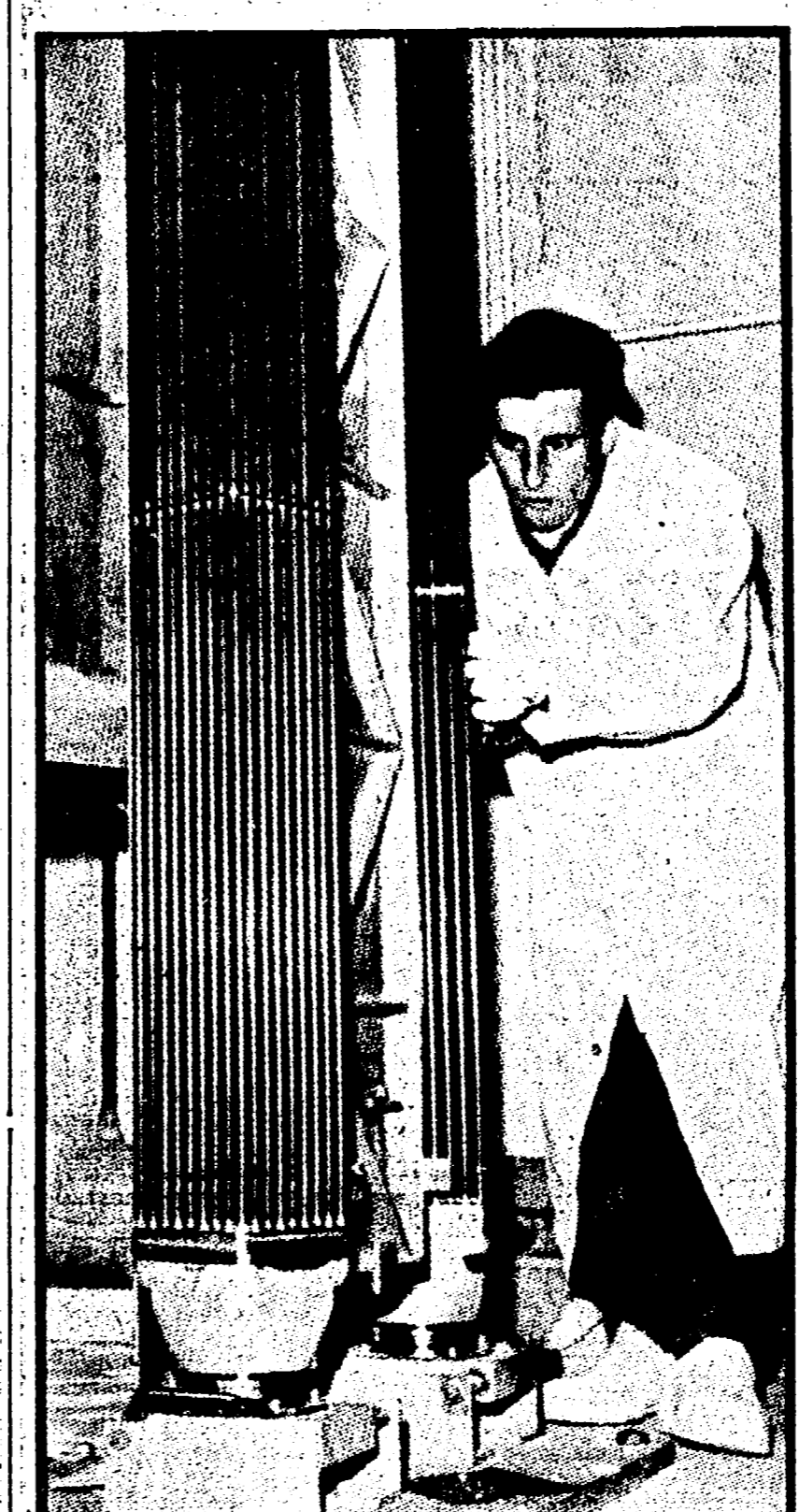
Le barre di combustibile del reattore del Garigliano
