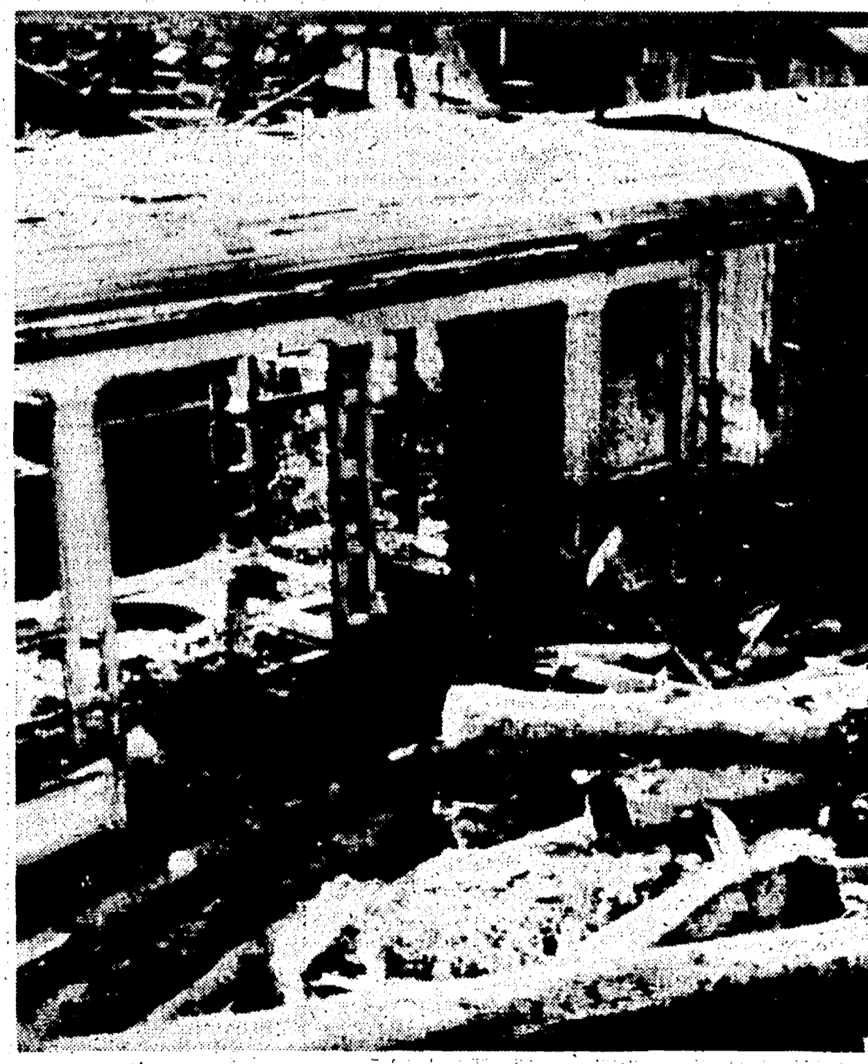
CAGLIARI — Il deposito delle ferrovie complementari, semidistrutto e invaso di detriti di ogni genere.
