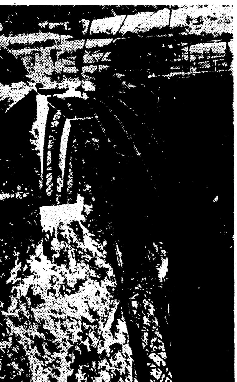
BOLZANO — A pochi chilometri da Ora, vicino al Passo San Lugano, è stata completata l'incastellatura di questo ardito ponte che con una sola campata di 120 metri, scavalca un burrone di 200 metri.
