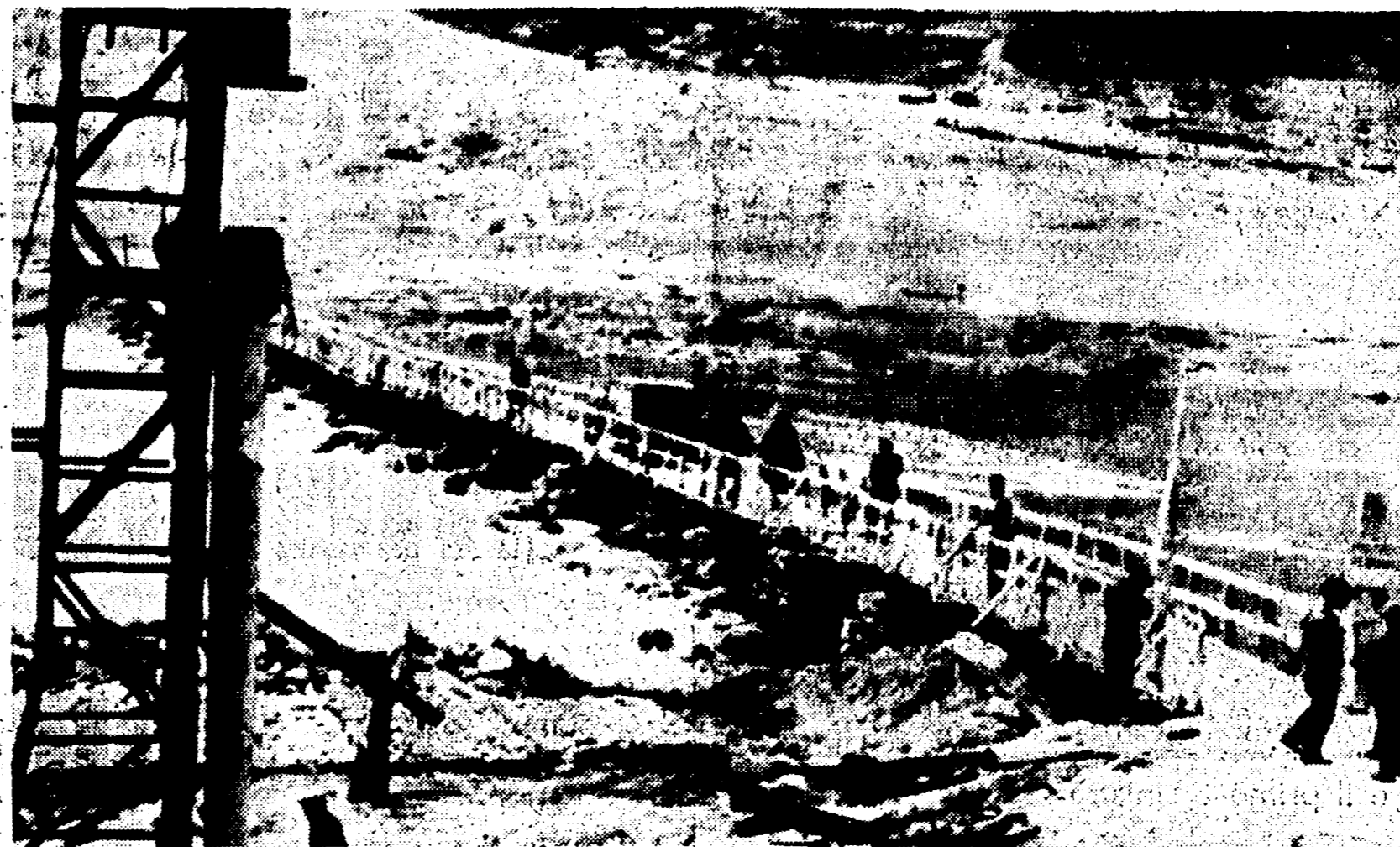
LONGARONE — Il ponte costruito sul Piave, dopo la tragedia del Vajont, che unisce Pirago a Dogna. (Telefoto ANSA-L'Unità)
