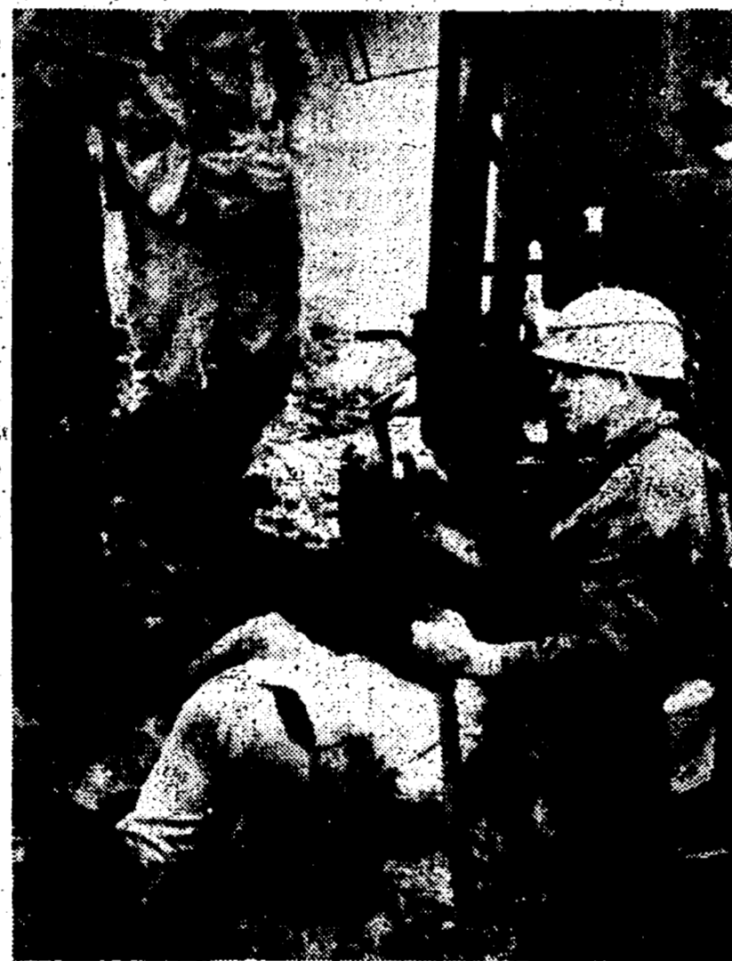
HANNOVER — In seguito al franamento di una falda di roccia un'enorme massa di acqua si è abbattuta sulle gallerie di una miniera nei pressi di Hildesheim. Cinquantacinque minatori sono rimasti bloccati nel sottosuolo. Le squadre di soccorso sono riuscite a prendere contatto con un gruppo di sette di essi che, dopo un lavoro frenetico durato più di dodici ore sono stati tratti in salvo nella serata di ieri. Nella foto: ANSA: uno dei soccorritori, sdraiato in terra, parla attraverso un tubo con i sette « sepoltri vivi ».
