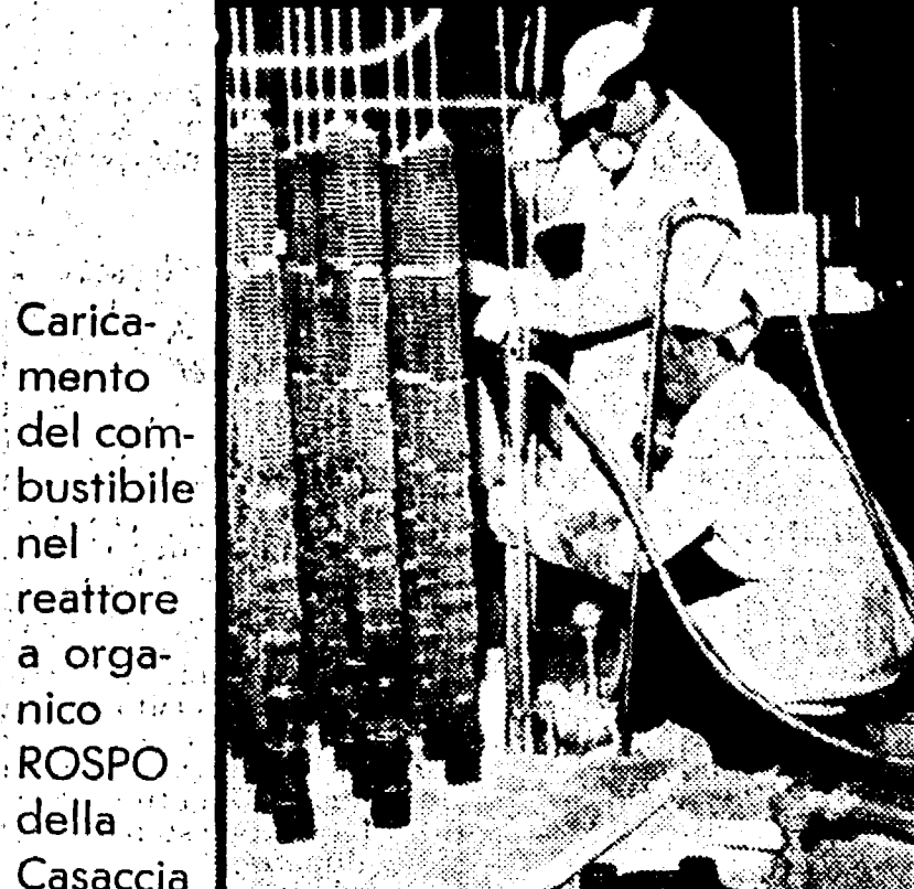
Caricamento del combustibile nel reattore a organico ROSPO della Casaccia
