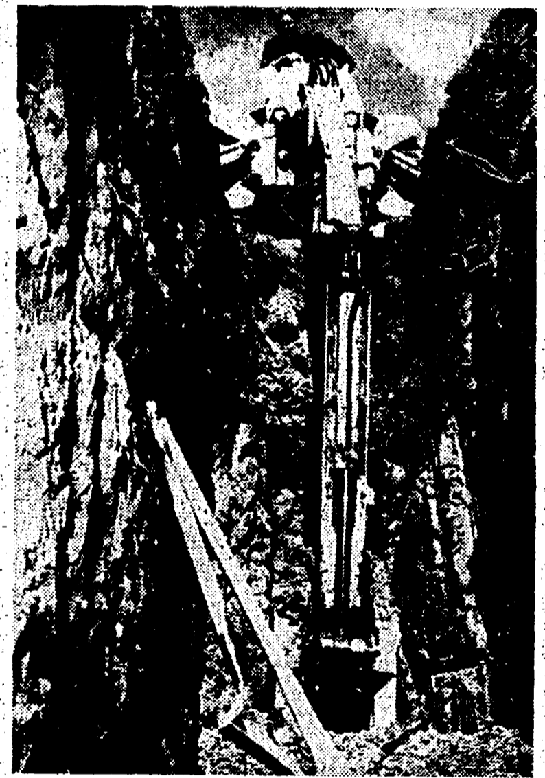
Questa escavatrice gigante, impiegata negli USA per tracciare canali d'irrigazione e lavori similari, potrebbe essere molto utile per i lavori di grande trasformazione fondiaria necessari in talune regioni italiane. L'acquisto e la gestione di una macchina del genere, però, richiede l'intervento di enti di irrigazione o di sviluppo, oppure grandi consorzi irrigui di contadini.
