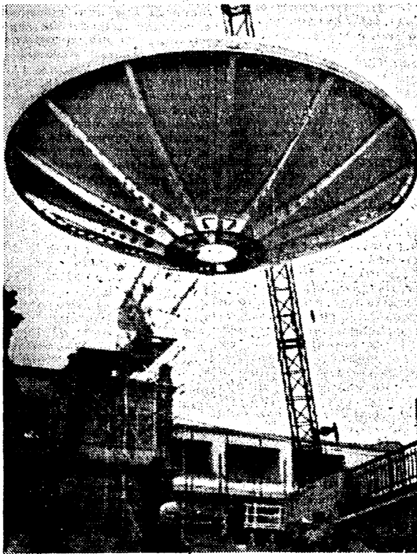
FIRENZE — I tecnici stanno montando in questi giorni, all'Osservatorio Astronomico di Arcetri, un radiotelescopio del diametro di 10 metri. Si tratta del primo strumento del genere messo a punto in Italia...
