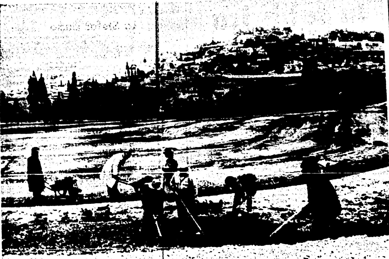
GERUSALEMME — Operai al lavoro sulla strada per il monte Sion, che sarà percorsa da Paolo VI.
