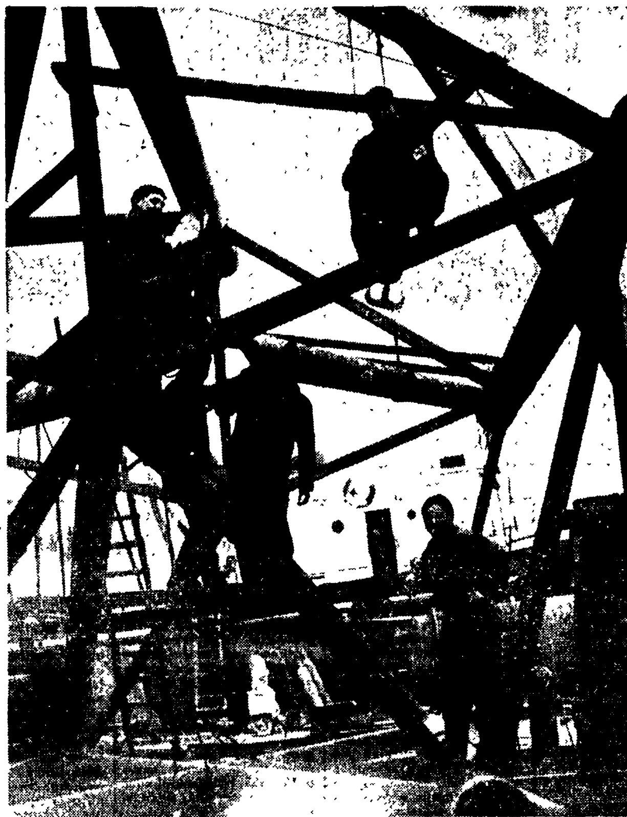
Una delle strutture metalliche dell'isola artificiale in costruzione
