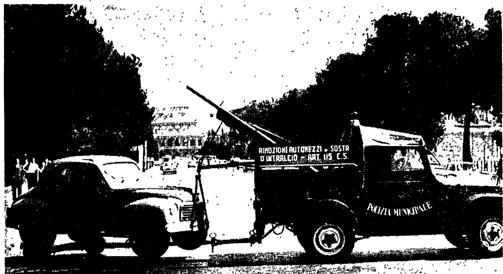
Autogru in azione in via Fori Imperiali
