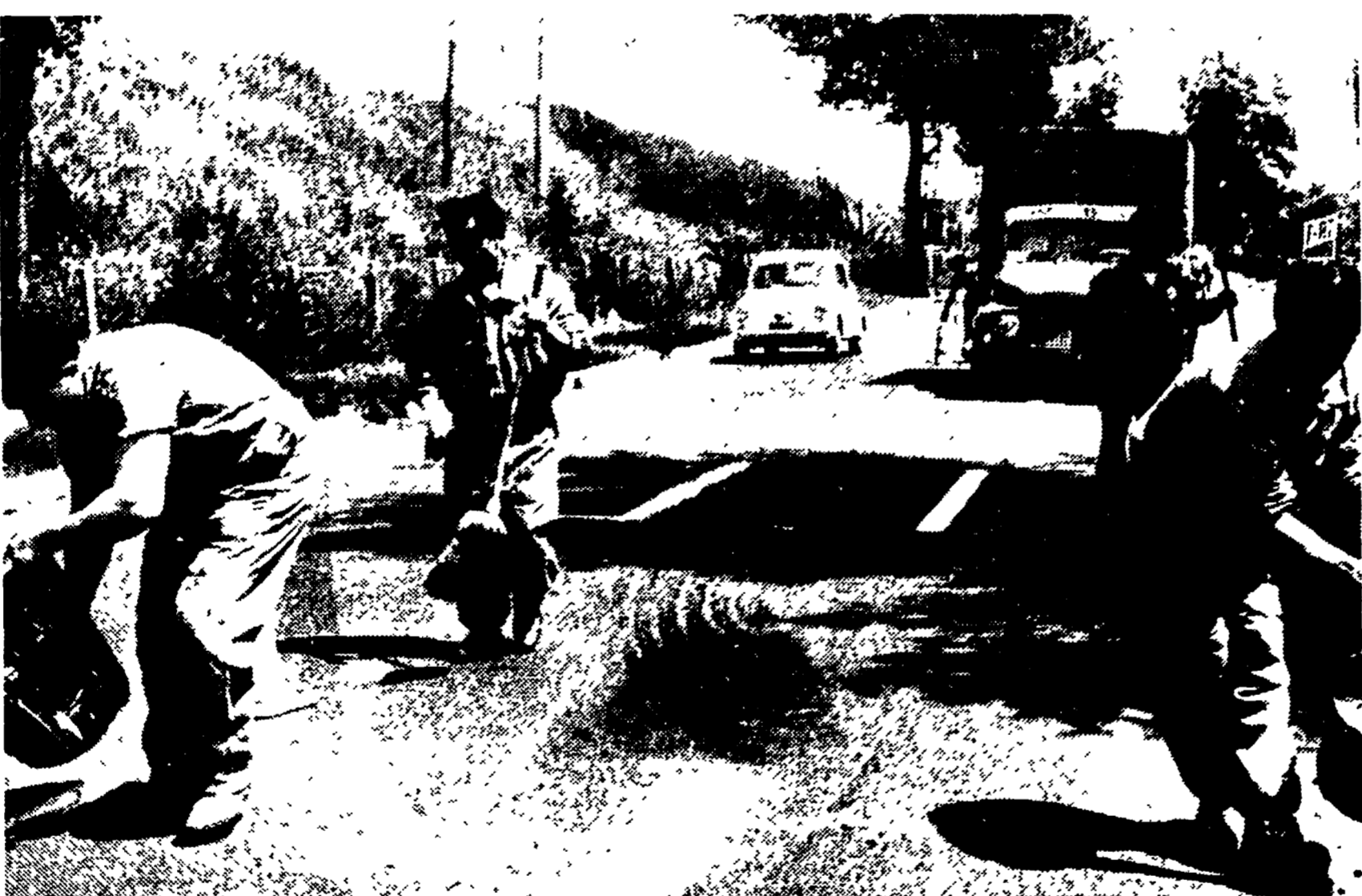
Finalmente, si sono decisi ad abolire la terza corsia, la famigerata corsia della morte, anche sulla «via del Mare». Nella foto, operai tracciano la nuova segnaletica
