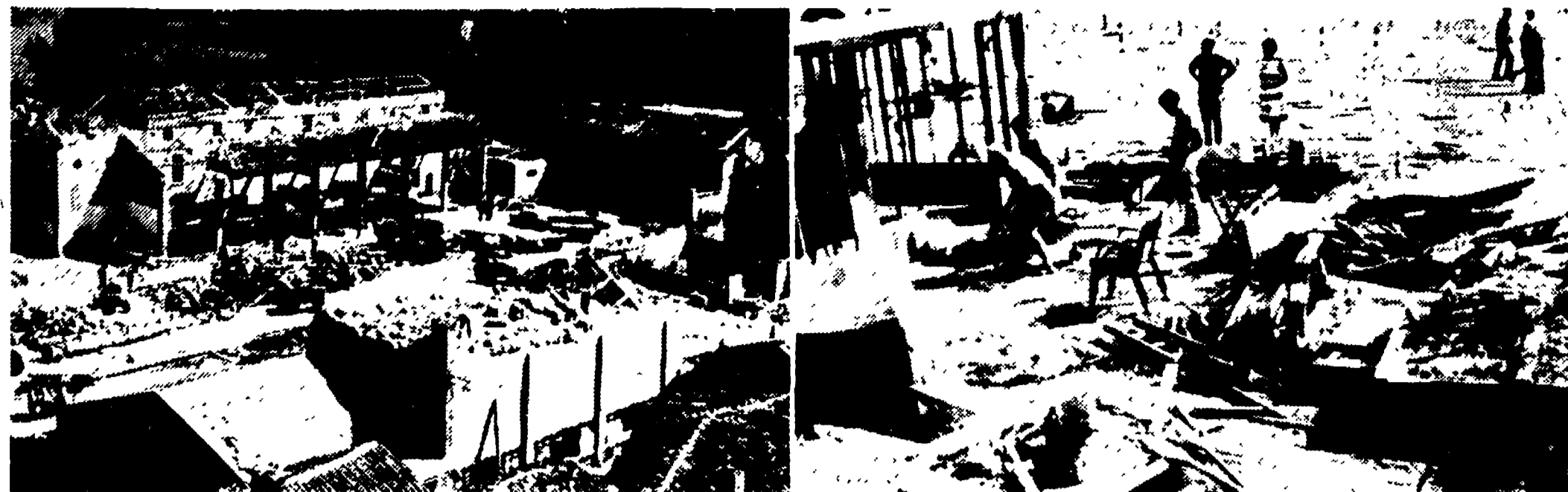
Un gruppo di case di Oflaga, nel Breselano, completamente scoperciate dall'uragano. Ingenti i danni anche nelle campagne. (A destra): un gruppo di cabine della spiaggia di Riccione sventrate dalla violenza del mare. (Telefoto)
