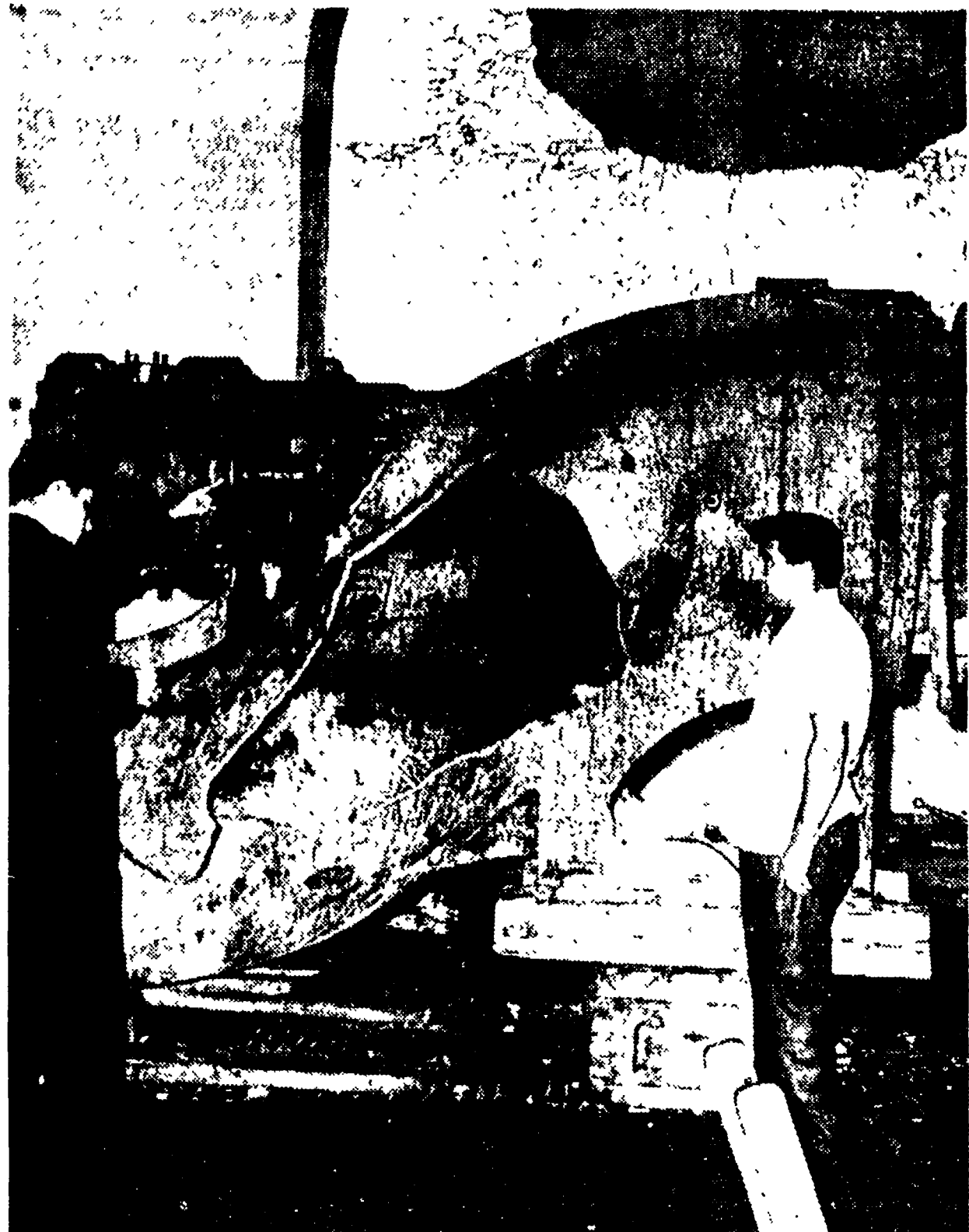
La tubazione «scarico sincrono» squarciata dall'esplosione.
