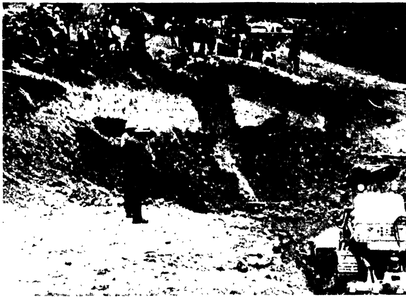
CHAMPAGNOLE — Un bulldozer al lavoro scava tra le tonnellate di terra franata nel tentativo di poter aprire un varco attraverso il quale raggiungere i minatori (Telefoto AP - «L'Unità»)
