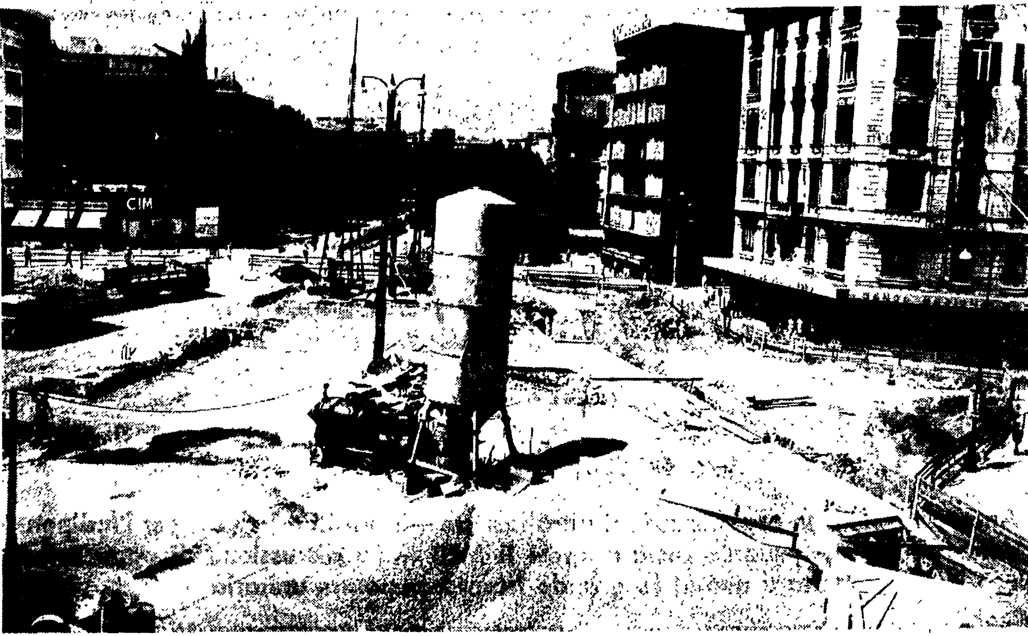
I lavori per la costruzione del sottovia di piazza Fiume sono appena agli inizi: si stanno preparando le intelature dei pali.
