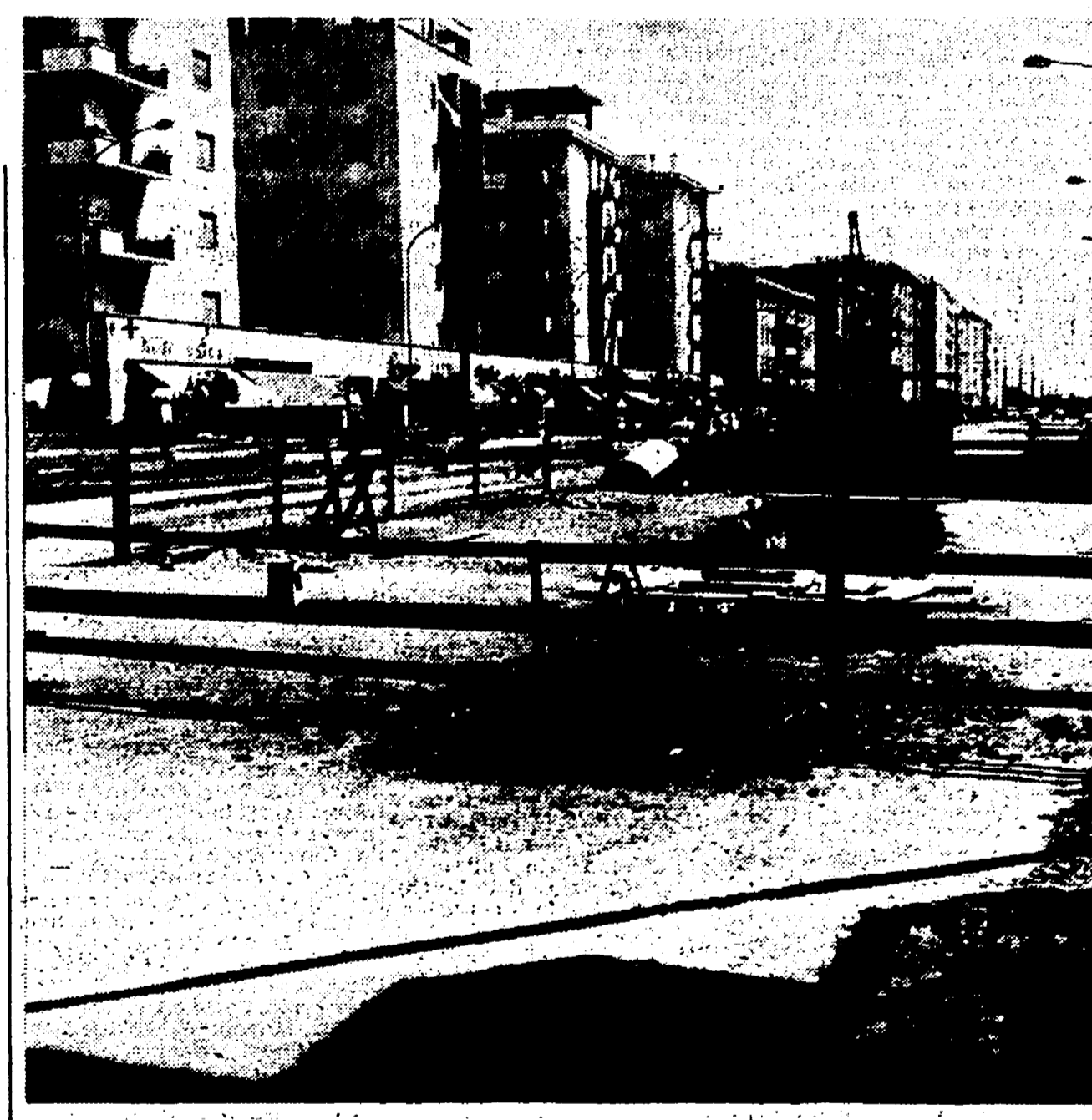
Via Tuscolana: uno dei cantieri che costruiscono la metropolitana. I lavori procedono a rilente.
