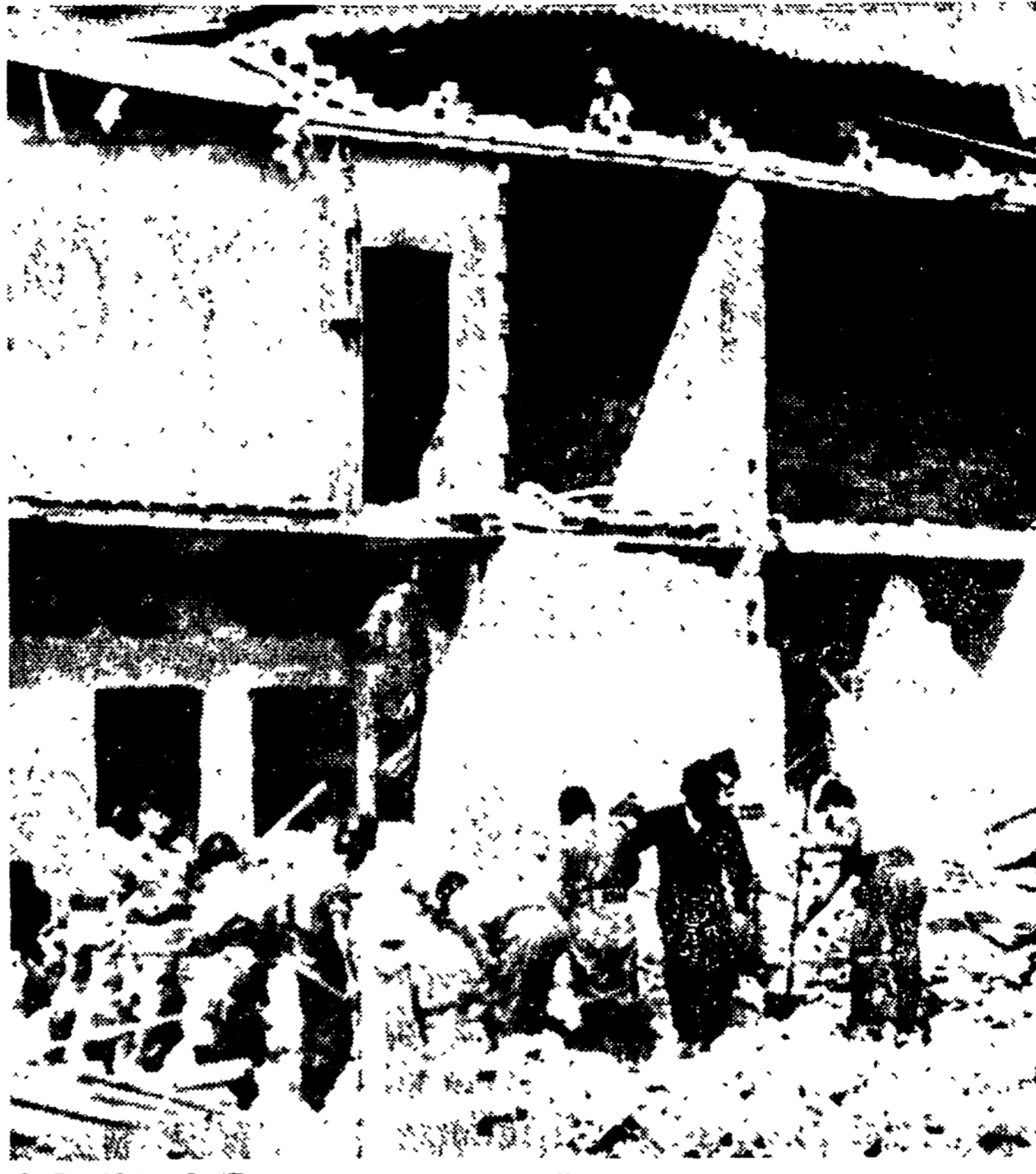
CARAVAGGIO (Bergamo) - Le squadre di soccorso dei vigili del fuoco al lavoro tra le macerie della casa crollata.
