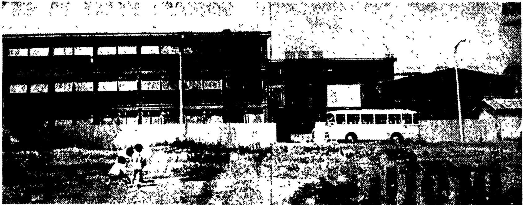
Il nuovo edificio scolastico di San Basilio
