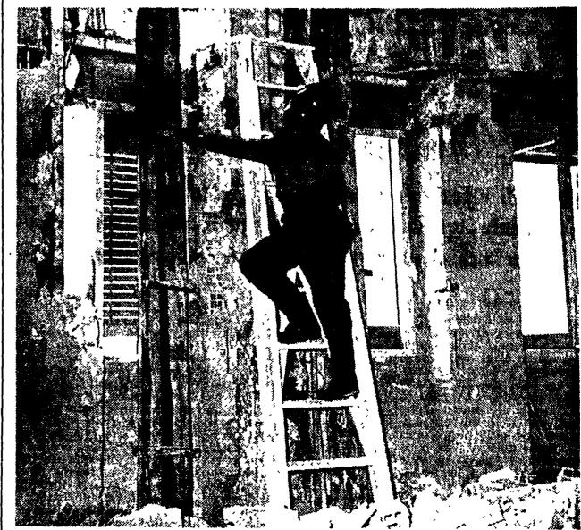
Sta rischiando di crollare, in via Accademia del Cimento 95, alla Fiera di Roma, una palazzina costruita solo otto anni fa. Due pilastri di cemento armato del basamento stanno sprofondando nello strato d'argilla sul quale poggiano le fondamenta e possono cedere da un momento all'altro. Le sedici famiglio che hanno domicili no state costrette a sgombrare in tutta fretta. ieri dopo il sopralluogo dei vigili del fuoco Hanno potuto portarsi via solo il minimo indispensabile mobili, abiti, masseri-
